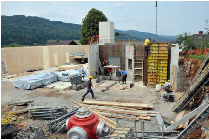
30. 6. 2019 Spodnja etaža dobiva svojo podobo - zidani del za kuhinjo in servisne prostore ter lesen montažni del za igralnice.
