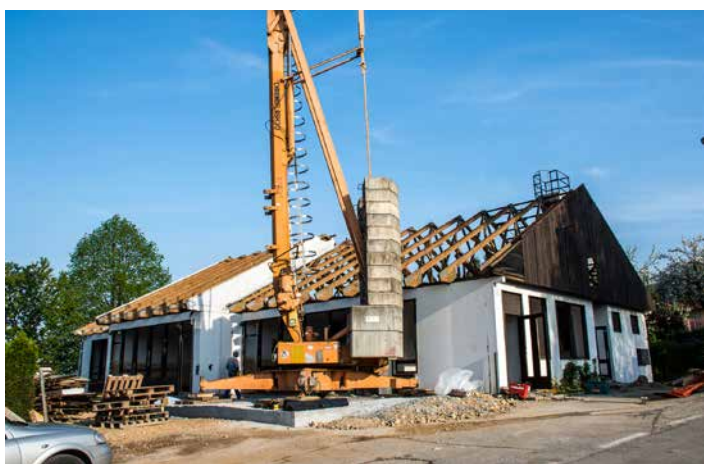
25. 4. 2018 Podoba starega vrtca po slabem tednu od začetka rušenja.
