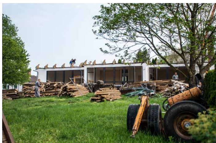
26. 4. 2018 Že naslednji dan so od vrtca ostale le še montažne stene.
