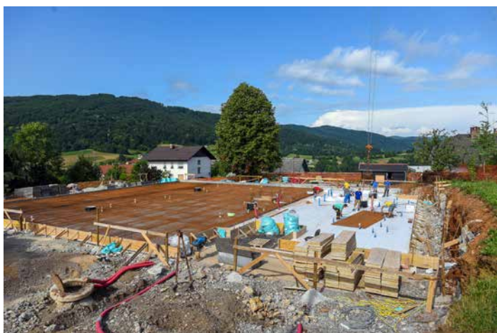
13. 6. 2018 Čez dober mesec je na istem mestu stala temeljna plošča za novo stavbo.
