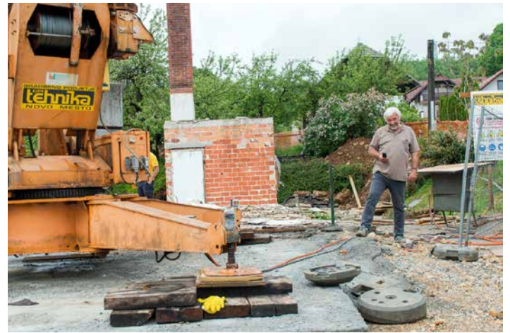
Vodja gradbišča gospod Korel je ves čas budno bdel nad potekom del.
