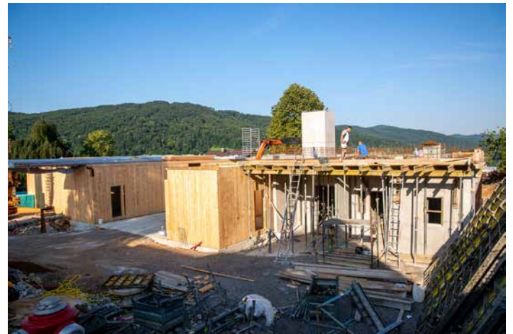
10. 7. 2018 Priprave na gradnjo zgornje etaže stavbe.
