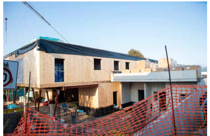
28. 8. 2018 Dograjena zgornja etaža – pripravljena na postavitve strehe.
