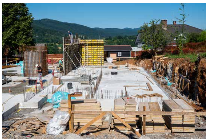
19. 6. 2018 Začetek postavljanja konstrukcije.
