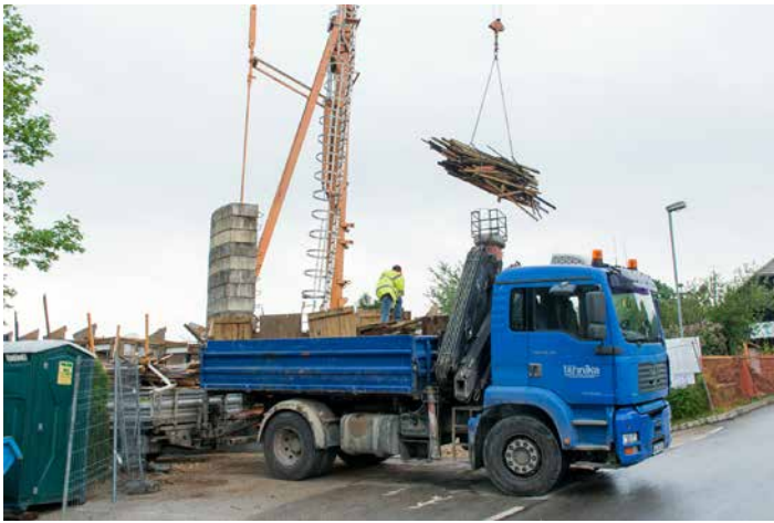
4. 5. 2018 Odvoz velikih količin gradbenega materiala.
