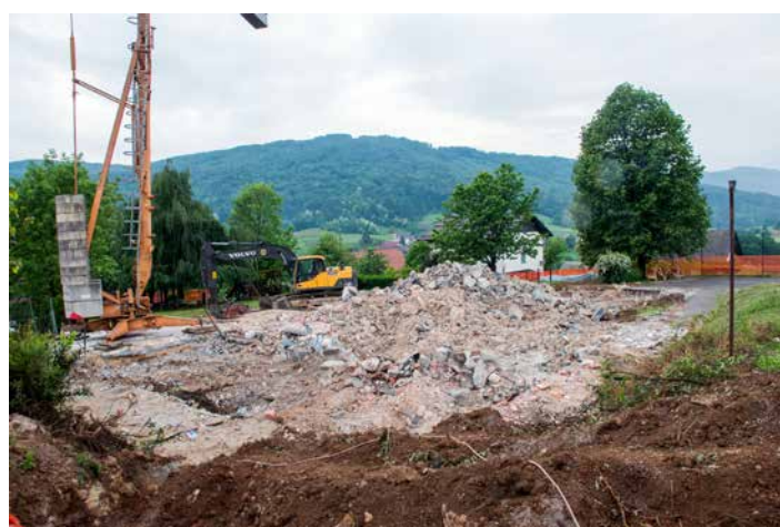
14. 5. 2018 Odstranjevanje temeljne plošče - še zadnjega dela starega vrtca.
